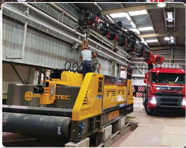
Ανύψωση μηχανής 14τ στα 17μ μέσα σε εργοστάσιο
