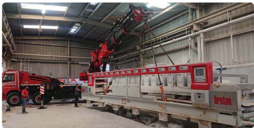
Ανύψωση σε κλειστό χώρο σε ακτίνα 11μ μηχανής λείανσης μαρμάρων 22τ
