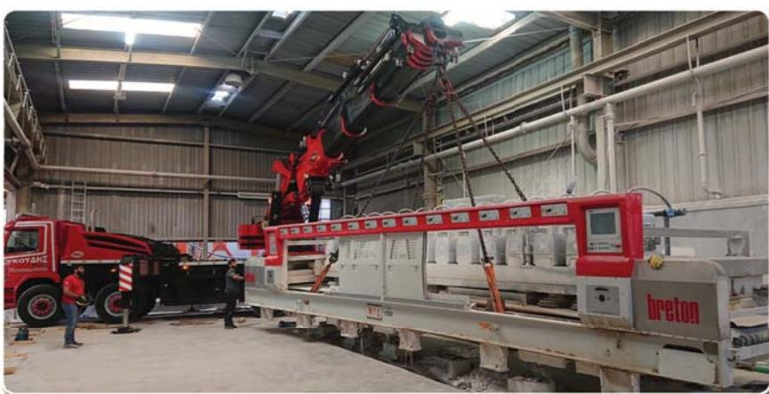
Ανύψωση σε κλειστό χώρο σε ακτίνα 11μ μηχανής λείανσης μαρμάρων 22τ
