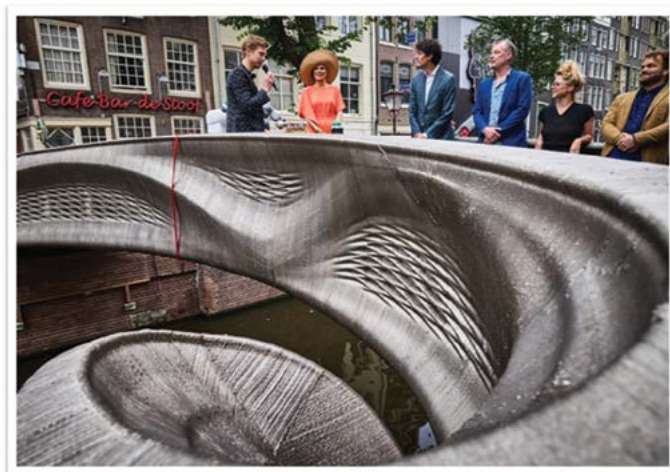
Εικόνα 5: Η πρώτη γέφυρα κατασκευασμένη με προσθετική κατασκευή στην Ολλανδία. Πνευματικά δικαιώματα φωτογραφίας: Jan de Groen.
